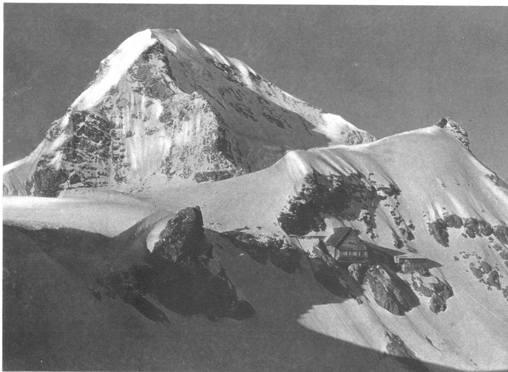
Ventilation in 3457 m über Meer. Berghaus Jungfrauoch
