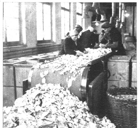
In einem grossen Altstoffsverwertungsbetrieb kommen die Postsendungen auf ein Fliessband. Das Verpackungsmaterial, nach Art und Qualität gesondert, wird von Hand so schnell als möglich in die bereitgestellten Kisten gelegt.
