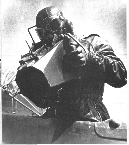
Das Auge des Beobachters: Die Kamera. Mit diesem Gerät, das für die Senkrechtaufnahmen im Innern des Beobachterplatzes, für Schrägaufnahmen über Bord gehandhabt wird, erreicht der Fliegerbeobachter dem Feind manch wichtiges Versteck. Diese Kamera ermöglicht es, feindliche Stellungen, Brücken, Munitionslager usw. genau festzustellen. Die Fliegerphotos sind die Wegweiser für Angriffe der Bomberstaffel im Hoch-, Tief- oder Sturzflug.
