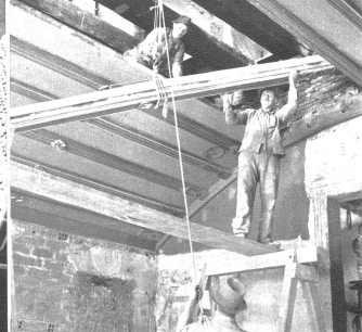
Sorgfältig werden die mit Wappen geschmückten Balken der gewölbten Holzdecke des alten Regierungsratsaal gelöst und abgenommen.
