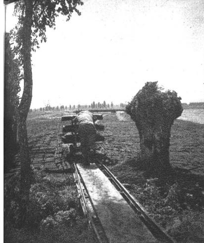
Mit Rollwagen wird der Torf auf die weiten Felder zum Trocknen geführt.
