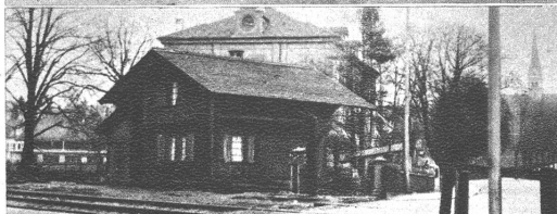
Der Schulweg-Niveauübergang mit dem bekannten Wartenhaus
