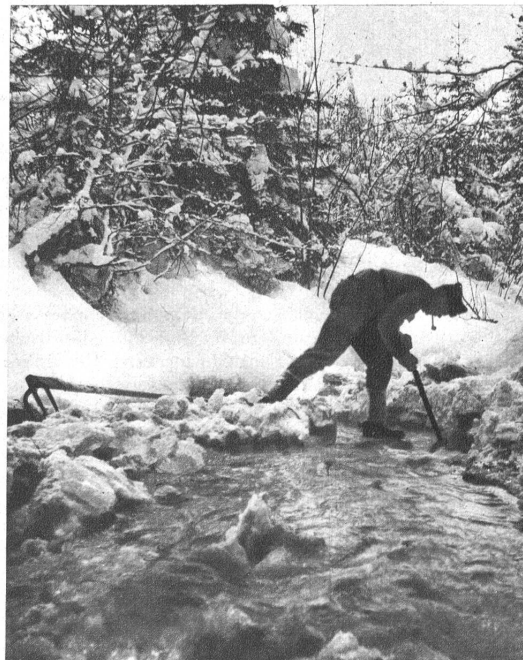
Mit Hacke, Pickel und Schlegel wird Stein um Stein herausgeholt. Kaum auf dem Trockenen, bildet sich eine dünne Eisschicht auf den Kieselsteinen und auch auf den verschiedenen Schuhen, die mehr als liebsam mit dem Eiswasser Bekanntschaft machten
