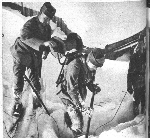
Kein Vergnügen, Leitungsbau im metertiefen Schnee! Das Material am Rücken wiegt mit der vollen Rolle an die 30 kg
