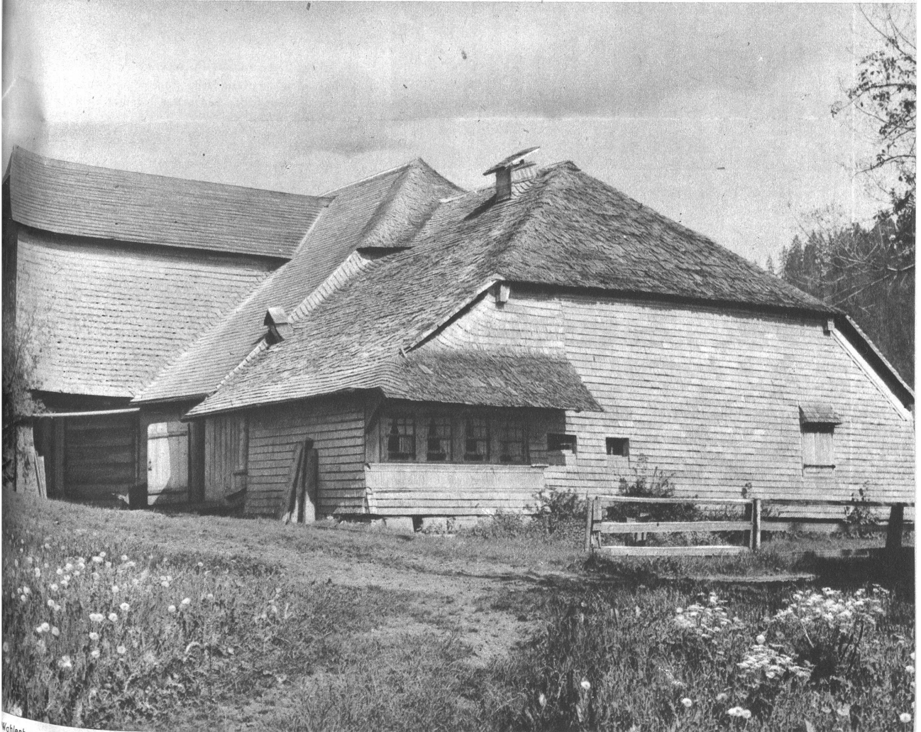
Wohlfühlhaus, hinter dem Schwendelberg: Die Wetterseite ist vom First bis zum Sockel mit Schindeln „gepanzert“ zum Schutz gegen den Westwind, den Regen und die Schneestürme
