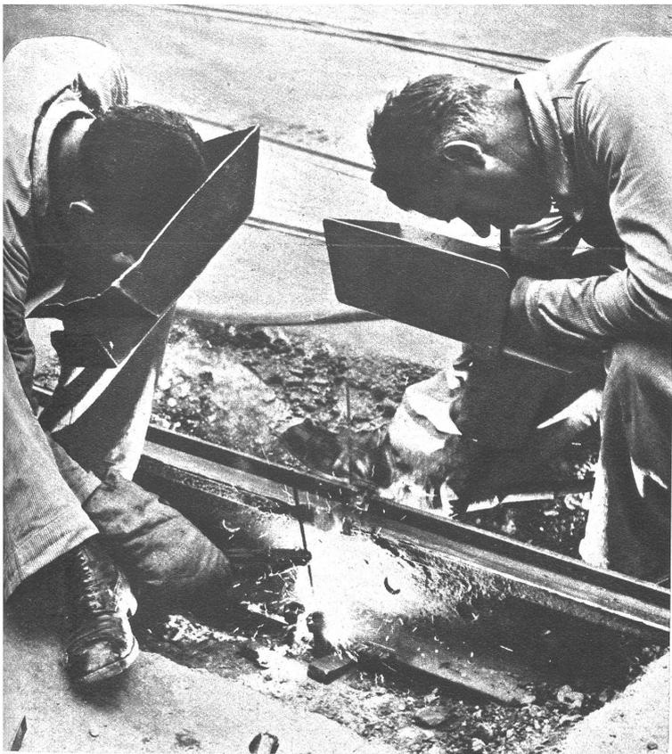
Vorerst wird eine Flusseisenplatte unterlegt und verschweisst, sodann die Lücke im Schienenkopf und im Steg mit Schweißgut ausgefüllt
