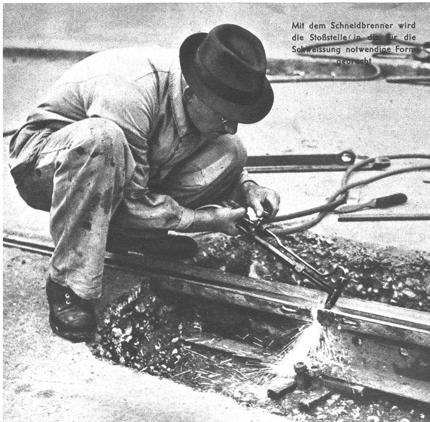
Mit dem Schneidbrenner wird die Stoßstelle in die für die Schweissung notwendige Form gebracht
