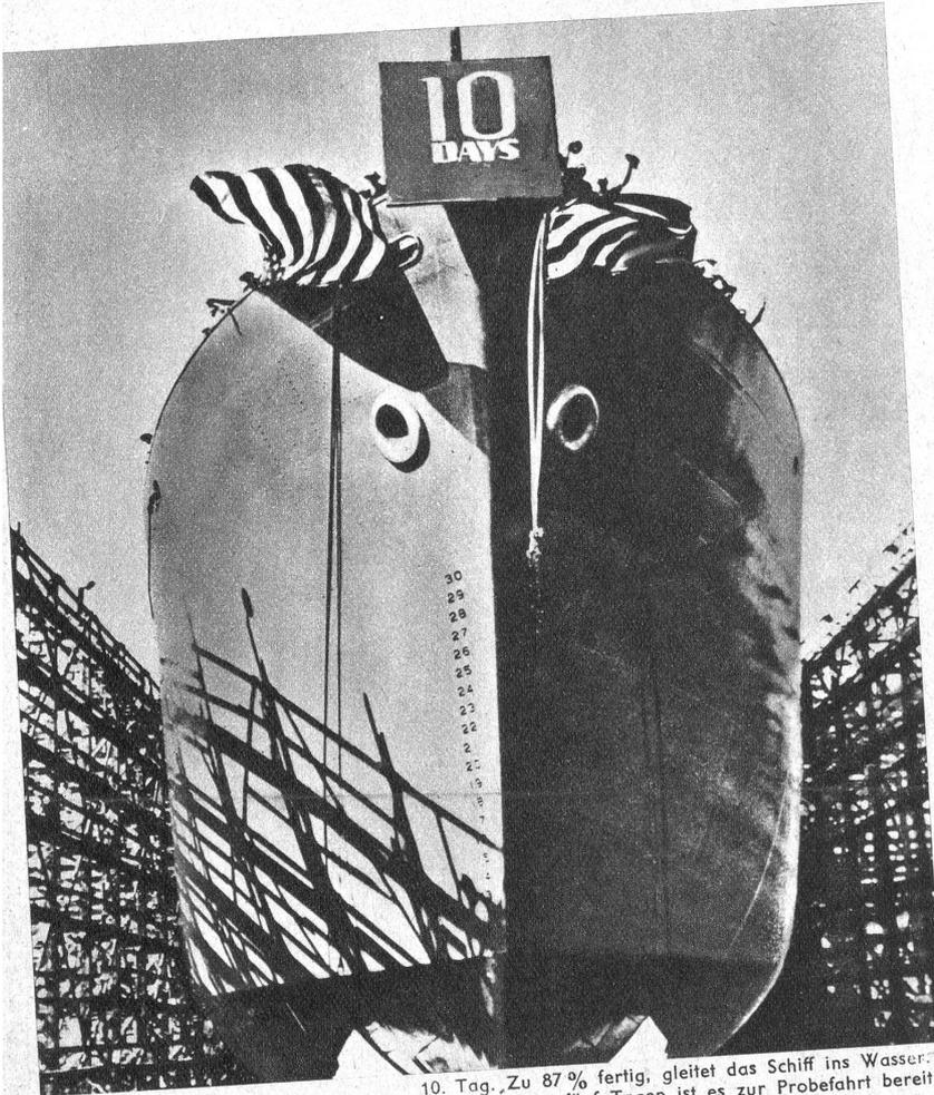
10. Tag. „Zu 87 % fertig, gleitet das Schiff ins Wasser. In weiteren fünf Tagen ist es zur Probefahrt bereit“
