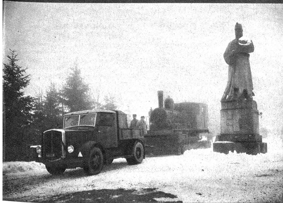
Durch den Tunnelleinsturz wurde die ganze Ajoie vom Bahnverkehr mit der übrigen Schweiz abgeschnitten. Um trotzdem die Linie Porrentruy-Courgenay aufrechterhalten zu können, wurde eine Dampf-Rangierlokomotive herbeigeschafft, die mit Rollschemel und Traktor nach Pruntrut geschafft wurde
