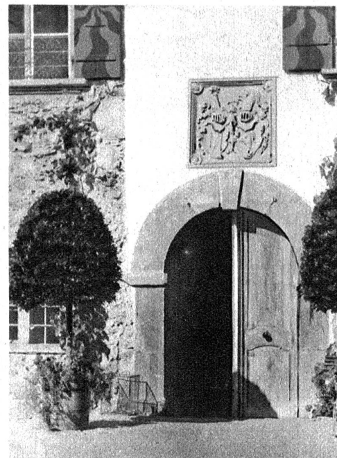
Der Eingang zum Palas. Ueber dem Türbogen befindet sich eine Supraporte von Franz Ludwig von Erlach und Salome von Steiger, 1601
