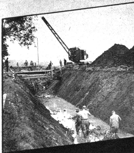
Aushub mit Bagger, im Vordergrund Aushub von Hand für die Querschwellen des Holzeinbaues
