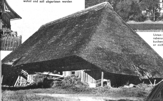
Oben: Dieser vornehme Wohnstock dient heute noch als Allenteil, Speicher, Backhaus und Waschhaus Unten: Vorratsspeicher von 1720 Das steile Dach verriet, dass auch dieser Bau ursprünglich mit Stroh gedeckt war
