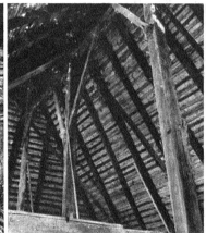
Links: «Althaus»-Einzelheiten. Der ganze mächtige Bau ruht auf gewolligen, verzäpften Eichenschwellen. Laubeläden und Fenstergerüste sind reich geschnitzt — Rechts: Heubühne des Althaus. Konstruktion eines Hochstuhls.
