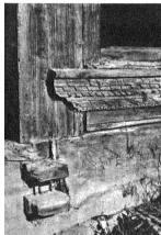
Links: «Althaus»-Einzelheiten. Der ganze mächtige Bau ruht auf gewolligen, verzäpften Eichenschwellen. Laubeläden und Fenstergerüste sind reich geschnitzt — Rechts: Heubühne des Althaus. Konstruktion eines Hochstuhls.
