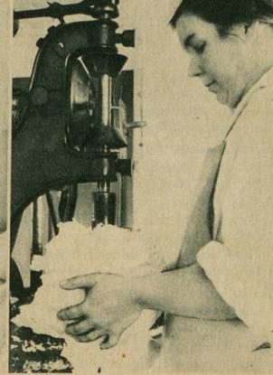
Zuerst wird den Häuptli an einer besonders dafür konstruierten Maschine der „Storzen“ ausgebohrt, der meist als Viehfutter Verwendung findet
