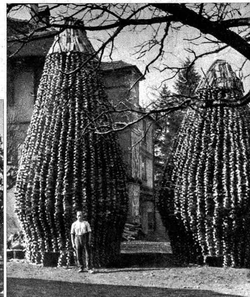
Oben: Bis 5 m hohe Scheiterhaufen werden errichtet. Der rillenförmige Aufbau dient der guten Durchlüftung und Austrocknung. Desgleichen soll der unten sichtbare Luftschacht verhüten, dass das Holz im Innern grau wird. — Links: Praktisch und zugleich kunstvoll aufgebaute Scheiterhaufen in Ersigen
