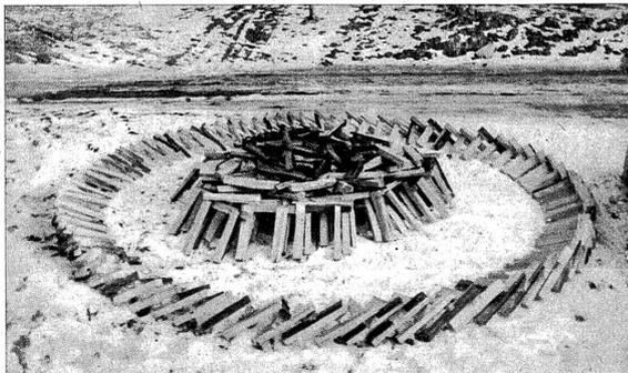
Oben: Auch zu einem einfachen Scheiterhaufen braucht es Geschick und Fachkenntnisse. Der rillenförmige Aufbau ermöglicht eine gute Durchlüftung
