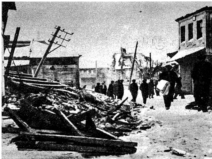
Oben: Die Erdbebenkatastrophe in der Türkei. Ein zerstörter Strassenzug der schwer heimgesuchten anatolischen Stadt Gerede. Neben vielen Todesopfern und Verwundeten gab es zahlreiche Obdachlose
