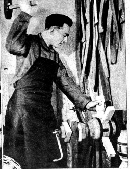
DER WAGNER. Das Bestücken mit den zugeschnittenen Speichen
