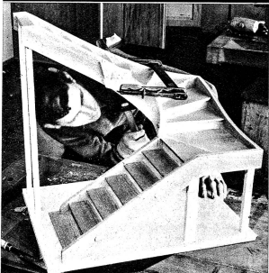
Der ZIMMERMANN arbeitet viel nach Modellen. Hier ein junger Arbeiter beim Bau eines komplizierten Treppenmodells
