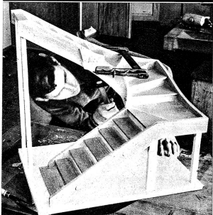
Der ZIMMERMANN arbeitet viel nach Modellen. Hier ein junger Arbeiter beim Bau eines komplizierten Treppenmodells
