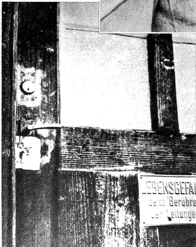
Links: Die verhängnisvolle, elektrisch geladene Türe, welche einem Arbeiter das Leben kostete und damit Anstoss gab zu einer polizeilichen Untersuchung. Die Türfalle wurde mit einer Spannung von 1600 V geladen
