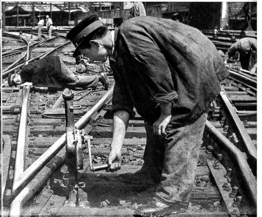
10 Tonnen Traglast überwindet die Stahlgeweiswinde, die zur Nivellierung der Schienen benützt wird. Nur ausgesuchtes Material und sehr gewissenhafte Ausführung garantieren für die Leistung
