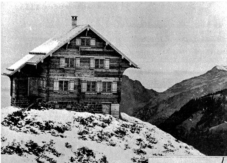
Die neue Lidernen-Klubbütte der Sektion Mythen wurde dieser Tage, nachdem bereits der erste Neuschnee gefallen war, feierlich eingeweiht. Das stattliche schmutze Berghaus am Ende des Riemensdaltales im Kaiserstockgebiet verfügt über 87 Schlaf- und 75 Wohnplätze. Die Baukosten beliefen sich auf 70 000 Franken Behörtl. bew. BRB 6216
