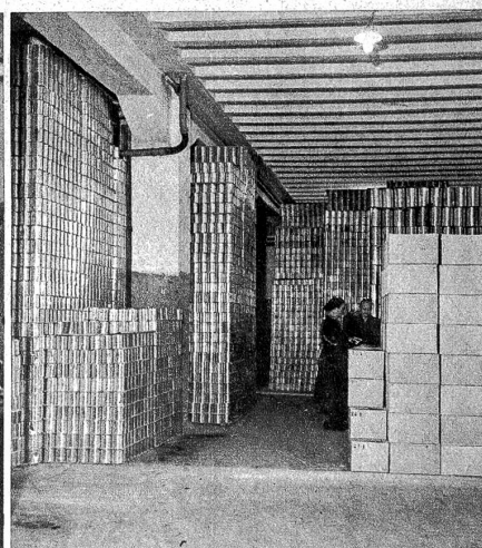
Teilansicht des Lagerraumes
