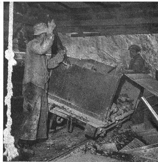
Kippen der Kastenwagen in das Brechermaul Unten: Lastschiff unter dem Transportband. Im Vordergrund Hausteine
