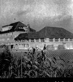
Das 1929 fertig gestellte Seidenberg-Schulhaus zwischen Muri und Gümliigen ist musterhaft gebaut und darf als eines der bestingerichteten Schulhäuser im Mittelland bezeichnet werden
