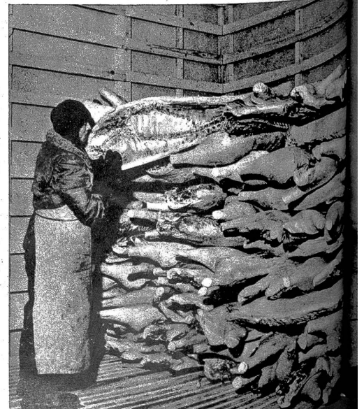
In der Tiefkühlanlage wird auch Fleisch bei einer Temperatur von -20^{\circ} tadellos aufbewahrt
