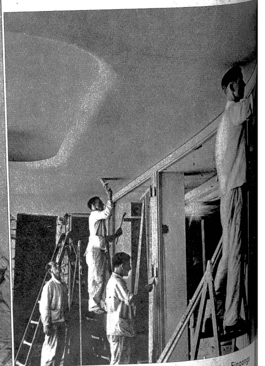
Arbeiten an den grossen Doppeltüren des Eingangs
