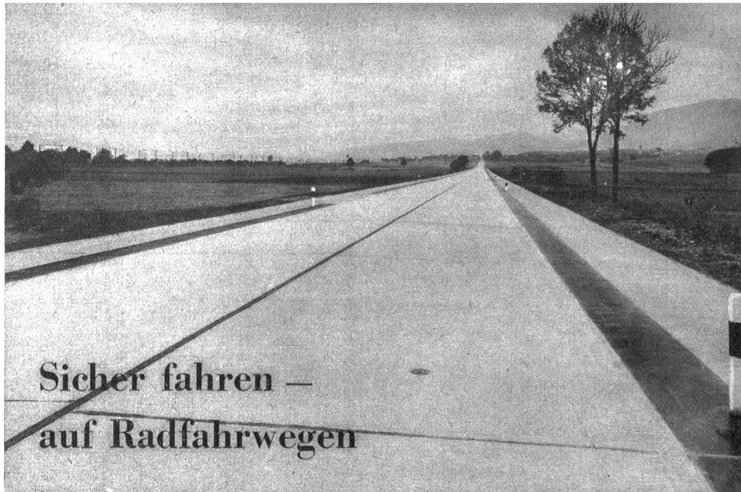
Die Betonstrasse Solothurn-Selzach. Beidseitig sind Radfahrwege mit schwarzen Sicherheitsstreifen und Abgrenzungspfosten
