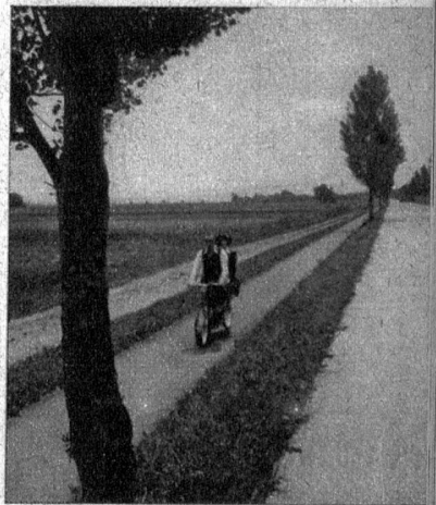
Auf der Strasse Killwangen-Spreitenbach. Hier ist eine Abtrennung des Radfahrweges durch Grünstreifen, daneben besteht ein Güterweg für landwirtschaftliche Fahrzeuge
