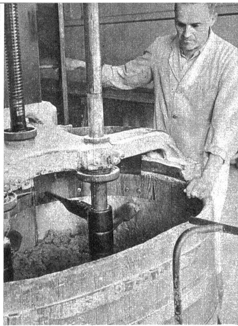
Knetmaschine für 280 kg Mehl
