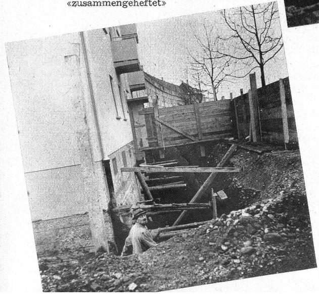
Oben: Man versucht, das Fundament der Bauten, das auf Stahlrosten steht, zu verstärken. Zu diesem Zweck müssen die Grundmauern freigelegt werden. Man vernimmt des weitern auch, dass zur Hebung der Bauten spezielle Pressluftapparaturen in Aktion gesetzt werden
