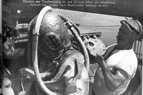
Obwohl der Taucherganz- en und für sich schon ein erhebliches Gewicht hat, müssen noch Bleiklumpen befestigt werden
