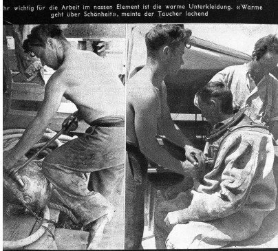
Ein Arbeiter beim Bereitstellen der Taucherausrüstung. Hier ist er gerade beim Ausschrauben des Luftschlauches am Taucherhelm
