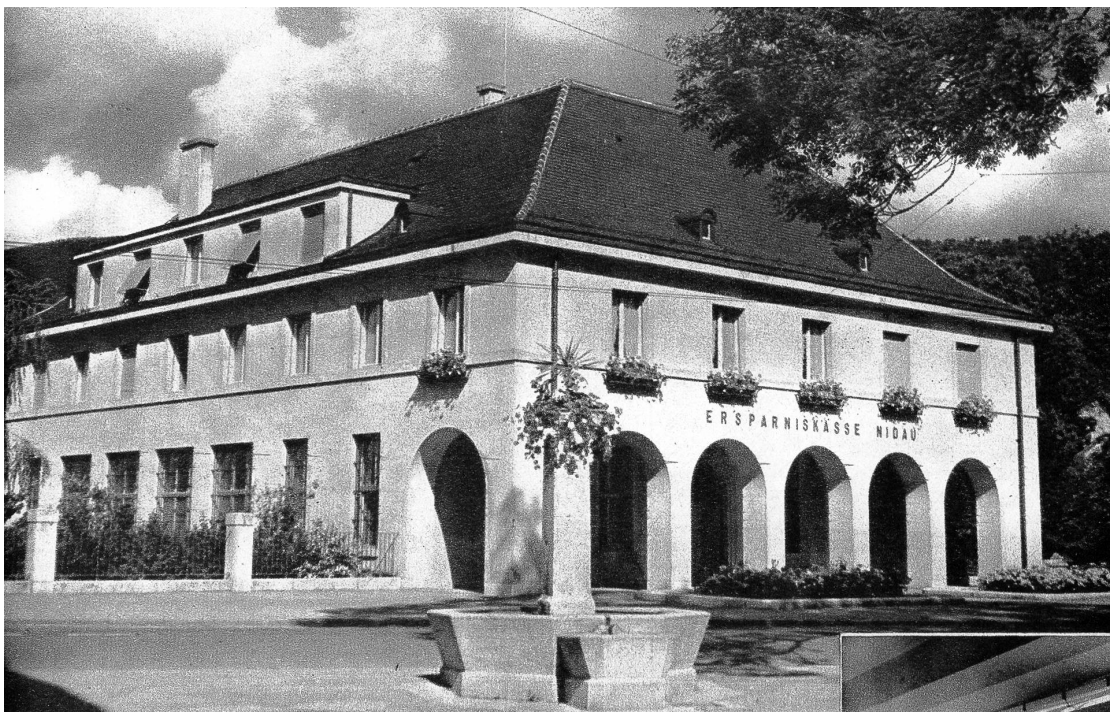
Ansicht der Ersparniskasse Nidau
