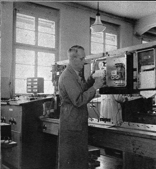
Hier werden Spezialzähler und Instrumente geeicht
