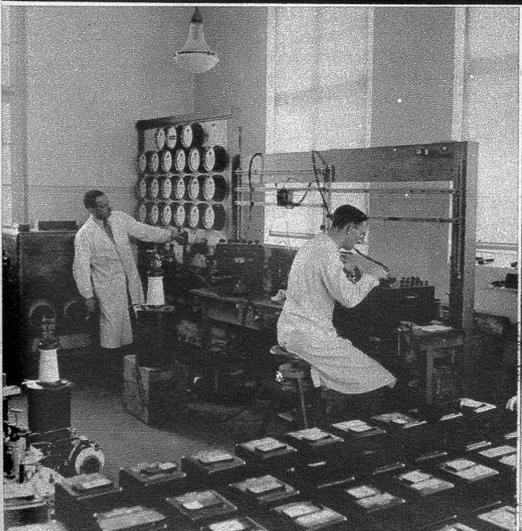
Prüfung eines reparierten Stromwandlers
