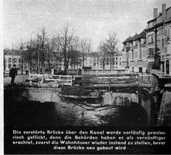
Die zerstörte Brücke über den Kanal wurde vorläufig provisorisch geflickt, denn die Behörden haben es als vorrätiger erachtet, zuerst die Wohnhäuser wieder instand zu stellen, bevor diese Brücke neu gebaut wird
