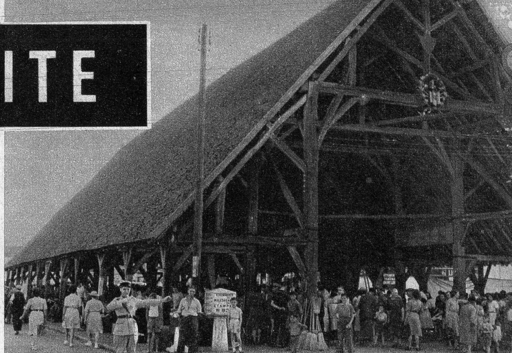
Eine der ältesten Markthallen der Welt besitzt die kleine französische Stadt Milly im Departement Seine-et-Oise. Der interessante Bau wurde im Jahre 1479 errichtet und ist vollständig aus Kastanienholz konstruiert.
