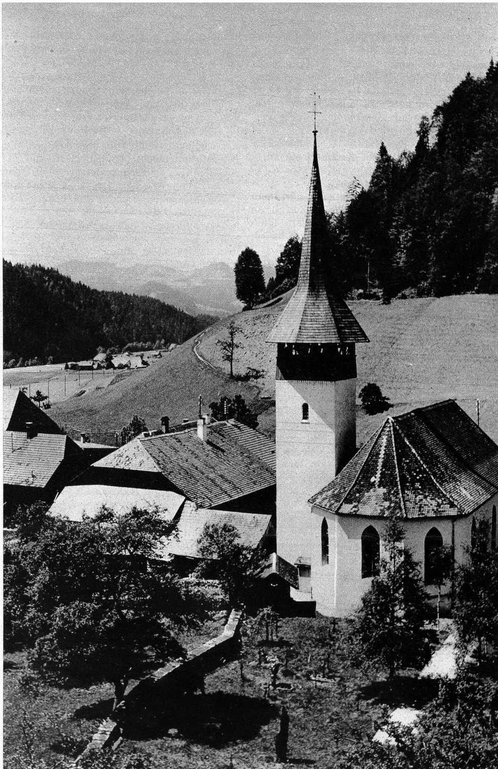
Kirche von Trüb (Photo H. Heiniger)
