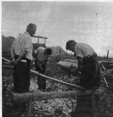
Bergbäuerliche Berufsprüfung im Simmental. Anfertigen eines Dachkanals
