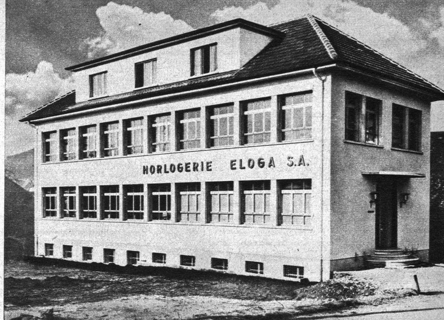
Die helle und sonnige Fabrikanlage der Eloga AG in Lengnau
