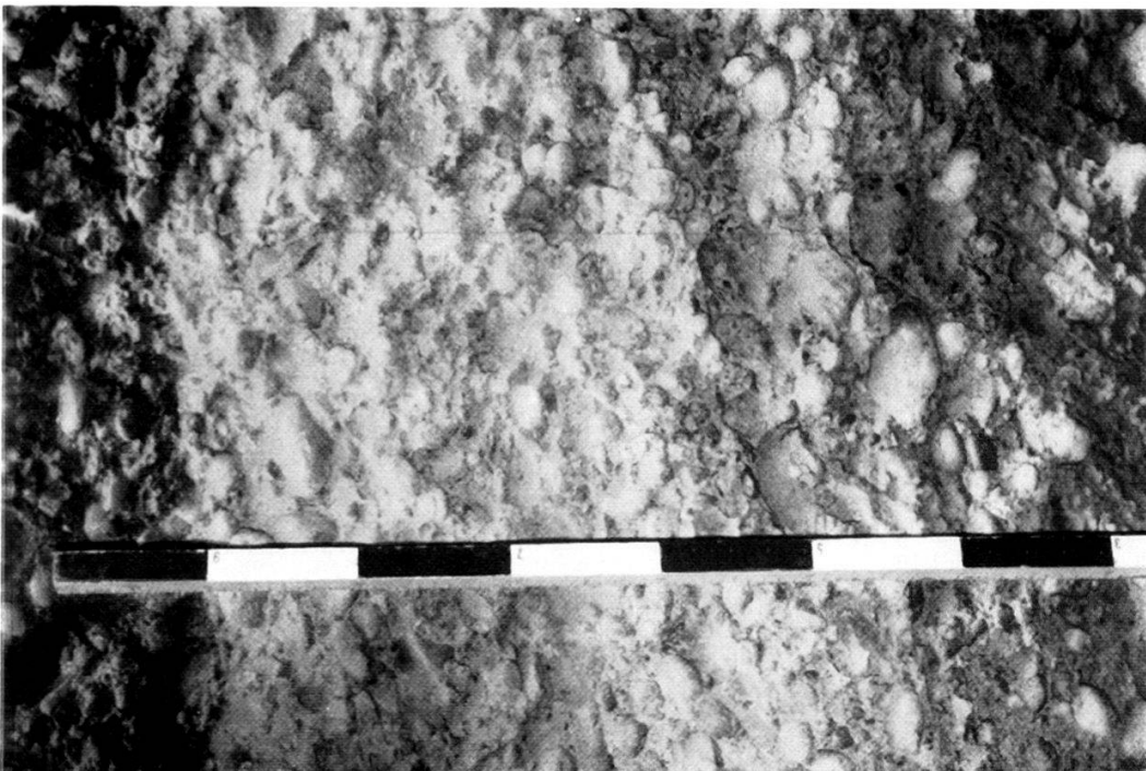
a) Rittergasse 22/24. Römischer Straßenkörper.
