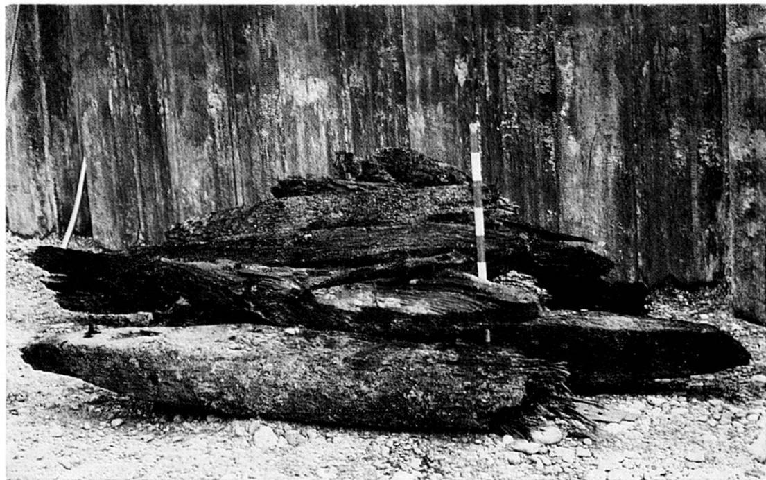
*Tafel 7 oben. Brückenreste bei St. Jakob 1968: Die Steinkonstruktion war durch den Bagger bereits durchwühlt. Im Vordergrund ein Stein mit Vertiefung für eine Eisenklammer.*
