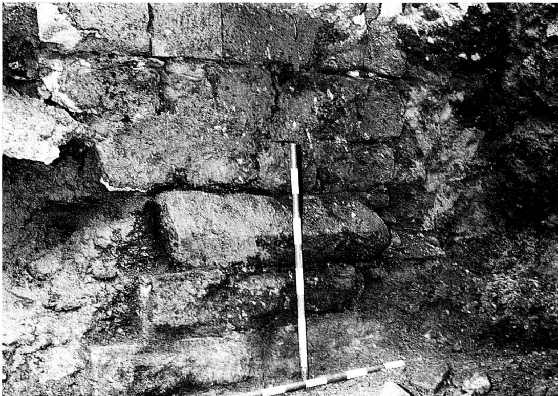
Tafel 6. Greifengasse 2 – Rheinbrücke: – Oben, Bossenquadermauerwerk des Brückenkopfes von 1225, untere Partie. – Unten, Übergangszone mit zurückspringendem Gesims, untere Partie Bossenquader mit Randschlag, obere Partie glatte Steine mit Verputz.
