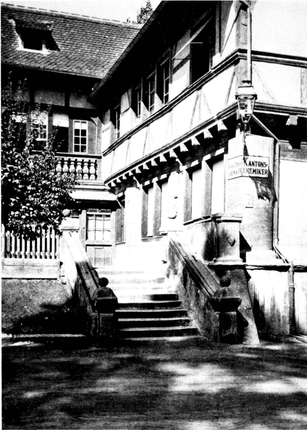
Abb. 14. Haupteingang des Stachelschützenhauses um 1910. Die Anschrift «Kantonschemiker» weist auf das bis 1916 hier untergebrachte Untersuchungslaboratorium hin.
