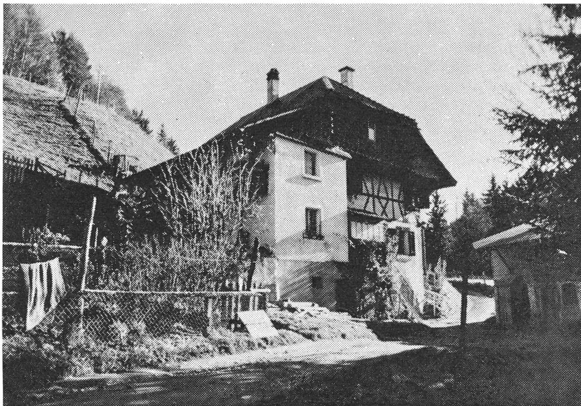
Die alte Pulvermühle am Galternbach, Gemeinde Alterswil, heute ein Wohnhaus.
