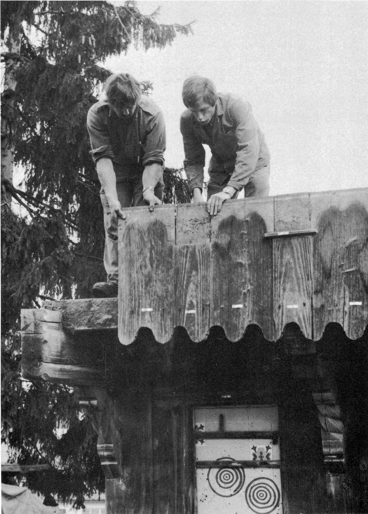
9 Die systematisch nummerierten Einzelteile werden sorgfältig demontiert. Dank der Elementbauweise, die keine Erfindung unserer Zeit ist, verspricht der Wiederaufbau auf dem Ballenberg zu einem faszinierenden Zusammenspiel zu werden. Berneroberrländer Handwerker vollziehen nach 200 Jahren ein zweites Mal den Schöpfungsakt ihrer Sensler Kollegen
