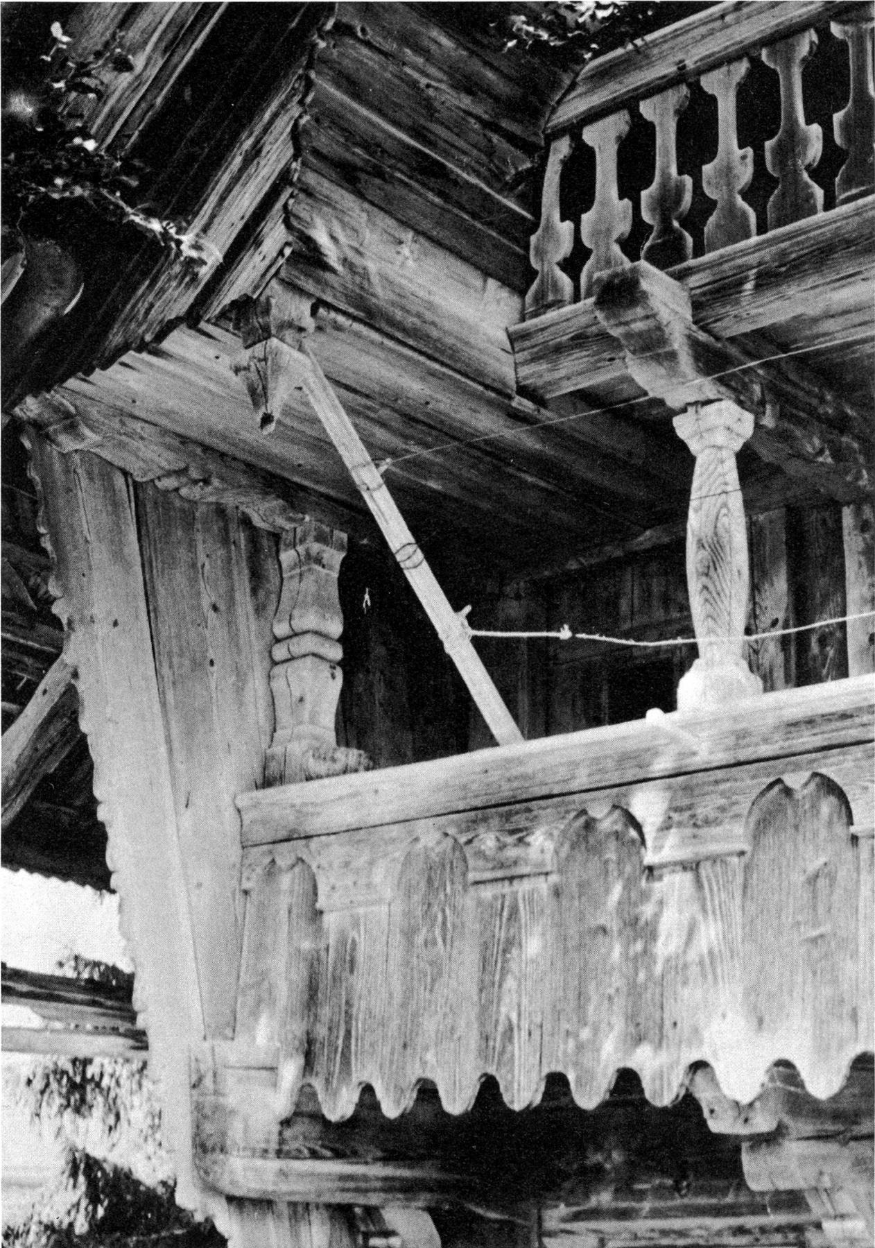
8 SW-Ecke mit Giebelbogen-Ansatz und schräger Wetterwand. Verschieden profilierte Holzsäulen. Untere Laube mit Arkaden-, obere mit Baluster-Täfer
