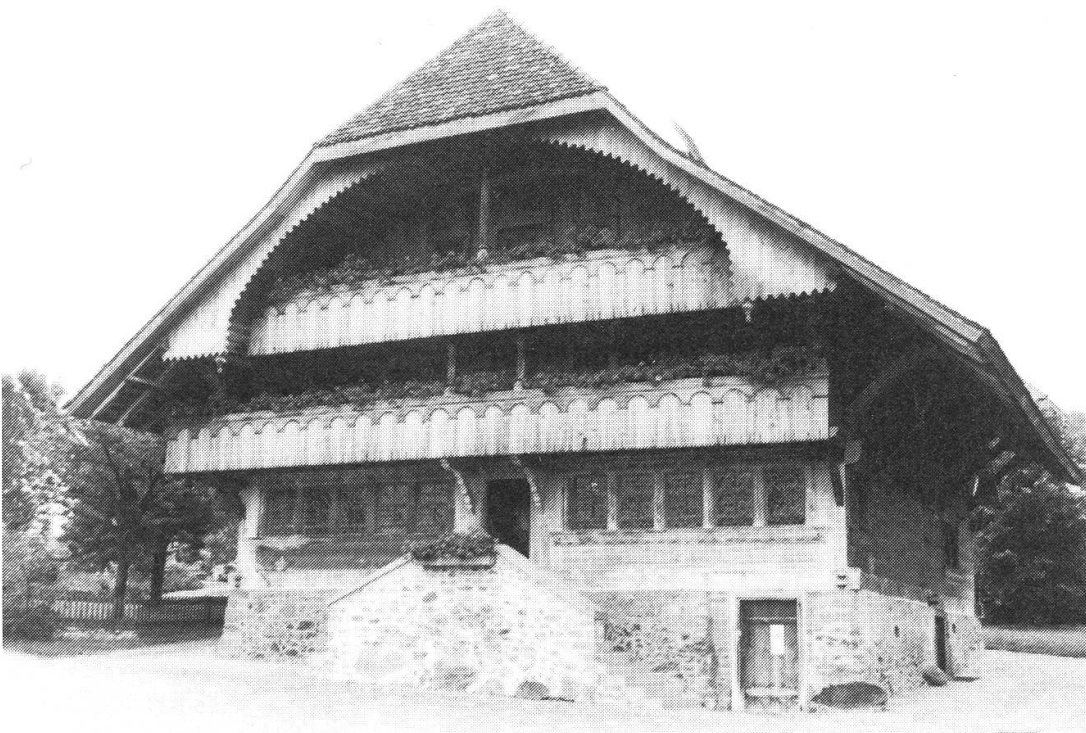
Das Heimatmuseum nach der Gesamtrestaurierung 1974/75.
