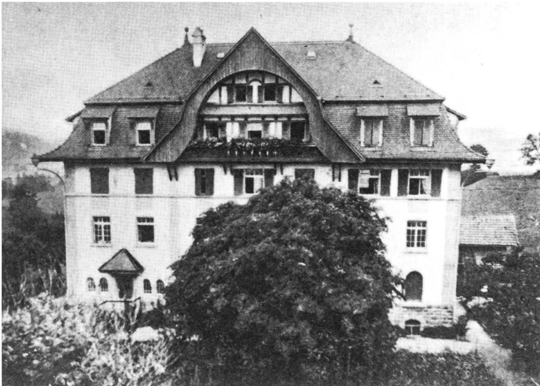
Das 1916/17 erstellte neue Pensionatsgebäude (Abb. zur Eröffnung des Schuljahres 1917/18). Um Verwechslungen mit dem gleichnamigen Kinderheim/Waisenhaus St. Vinzenz zu vermeiden, wurde 1945 das Institut zu Ehren der Mitordensstifterin Ste-Louise de Marillac benannt.
