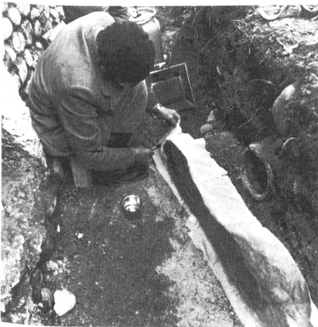
Abb. 42 Bösing. Bergung der Wandmalerei. Auftrag der Trennschicht
