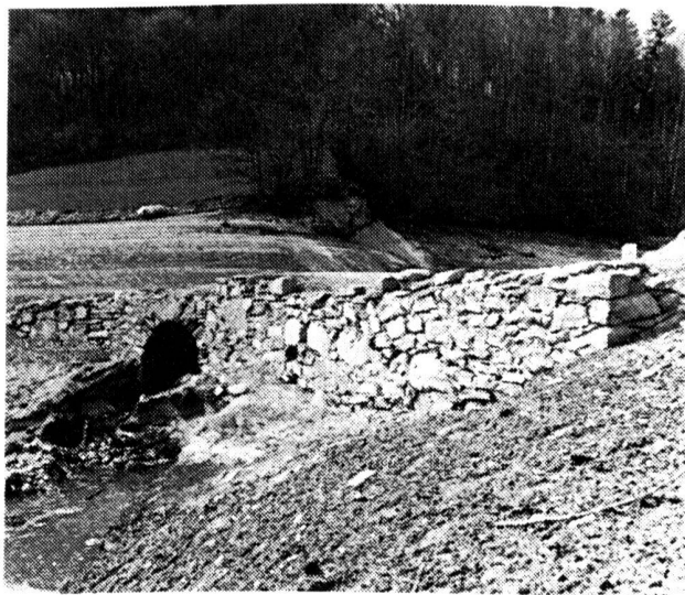
Fig. 38 Avry-devant-Pont . Détail du pont romain
