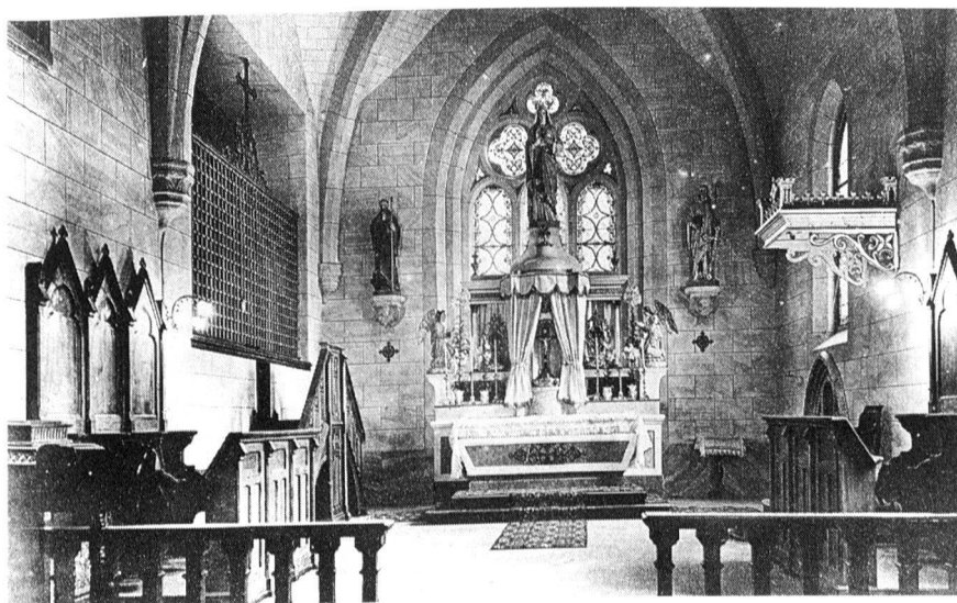
Fig. 76 Sanctuaire et grille du choeur des moniales, état vers 1910
