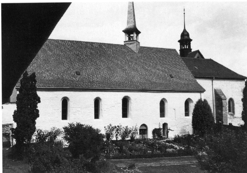
Fig. 17 Le mur sud de la nef en 1994, après la suppression des ajouts de 1873
