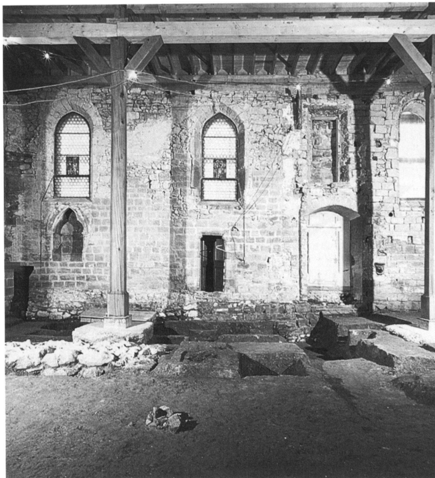
Fig. 4 Mur sud de la première église, vers 1270. De gauche à droite: piscine liturgique de la chapelle sud, porte de la sacristie (surmontée d'une fenêtre ayant remplacé en 1724-1726 la porte du dortoir des moniales) et porte du cloître
