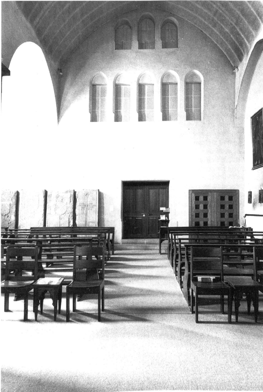
Fig. 83 Le mur de refend construit en 1873 entre la nef et l'hôtellerie, état vers 1990, après l'abaissement de la voûte et la suppression de deux fenêtres en 1908 et l'enlèvement du décor néogothique de la porte vers 1965. Comparer avec le dessin du Père Hartmann (fig. 81) (Photo: N. Repond, Bulle)
