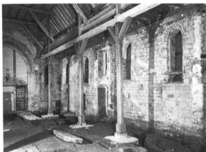
Fig. 18 Mur sud de la nef
