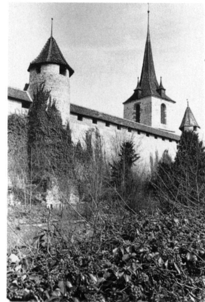
Abb. 75 Murten/Ringmauer. Ansicht der Ringmauer mit Pfaffenturm (im Vordergrund) und Katzenturm. Im Hintergrund der Turm der Deutschen Kirche
