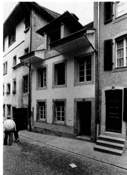
Abb. 71 (links) Murten/Kreuzgasse 11. Strassenseitige Fassade, Zustand während der Bauarbeiten Abb. 72 (unten) Murten/Kreuzgasse 11. Eines der zwei verkohlten Brote,
