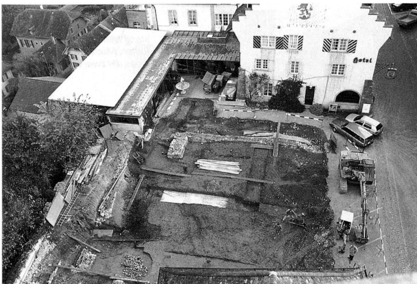
Abb. 74 Murten/Rathausgasse 3. Übersicht über das Grabungsfeld vom Donjon des Schlosses. Im Vordergrund der unüberbaubare Streifen, hinten die Mauerreste des mittelalterlichen Hauses und der Murtenhof.
