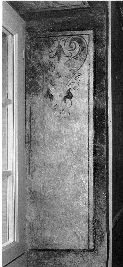
Fig. 34 (à droite) Fribourg/R. de la Neuveville 1. Décor du piédroit d'une fenêtre (1612/1613, maison n° 1, premier étage sur cour)
